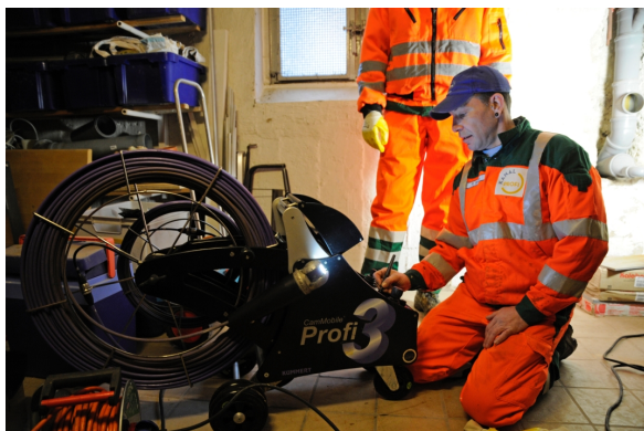
Kontrolle vor Ort: Am Monitor gleich neben dem Zugang zum Hausanschluss wird das Bild der Kamera geprüft.
