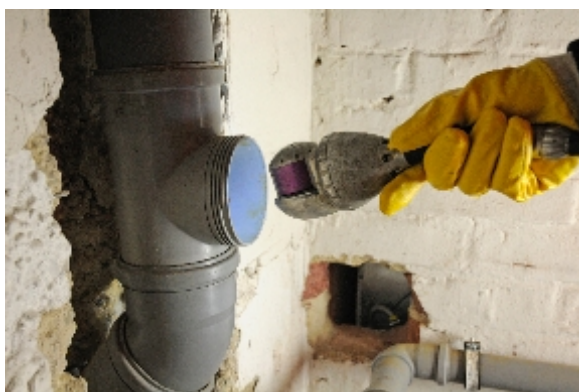
Passt perfekt: Die kleine Kamera kann mühelos in die Revisionsöffnung gesteckt werden.
