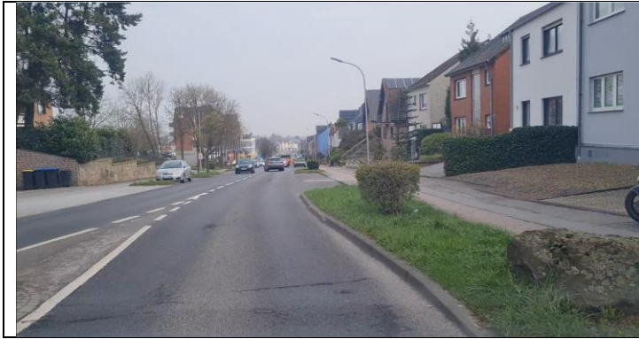
Streckenabschnitt L8 (hier: Jülicher Straße Fahrtrichtung Norden)
