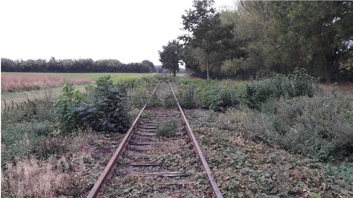
Abb. 8: Blick von Norden auf die Bahnstrecke; rechts Randgehölz der Kläranlage (Foto 25.09.2020).
