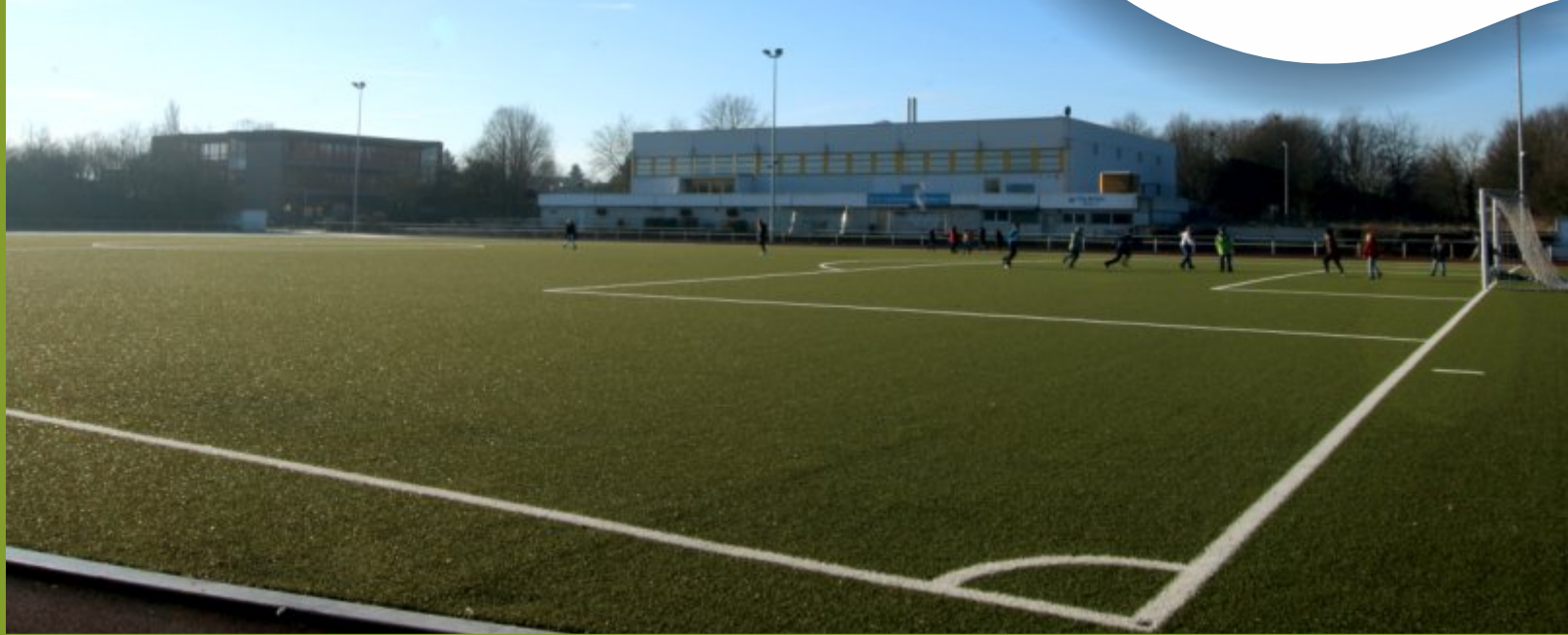
Schulsportanlage Gustav-Heinemann Gesamtschule mit Kunstrasenplatz und Dreifachsporthalle
