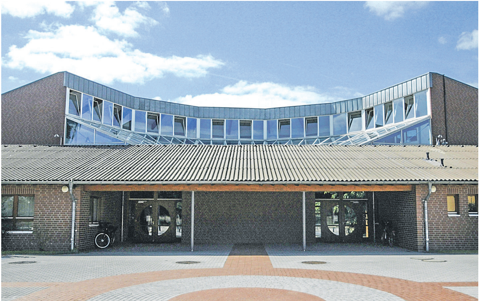
KURZE BEINE, KURZE WEGE: DIESES MOTTO SOLL BEI DEN ALSDORFER GRUNDSCHULEN IN DEN ORTSTEILEN AUCH IN ZUKUNFT GELTEN.
