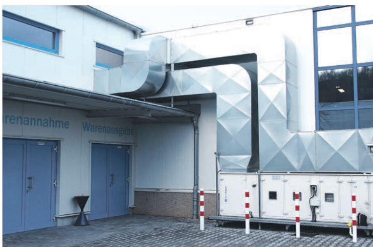
STRENG GETRENNT: DIE WARENANNAHME- UND -AUSGABE SOWIE ZU REINIGENDE- UND GEREINIGTE LUFT.
