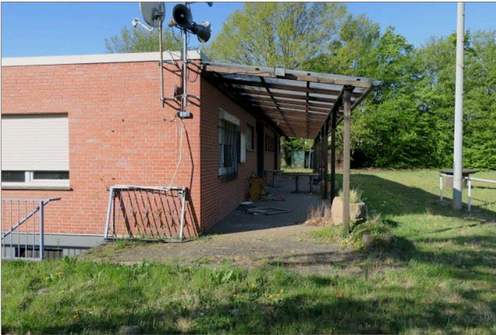
Foto 5: Aufgelassenes Vereinsheim mit Nebenflächen (von Osten)
