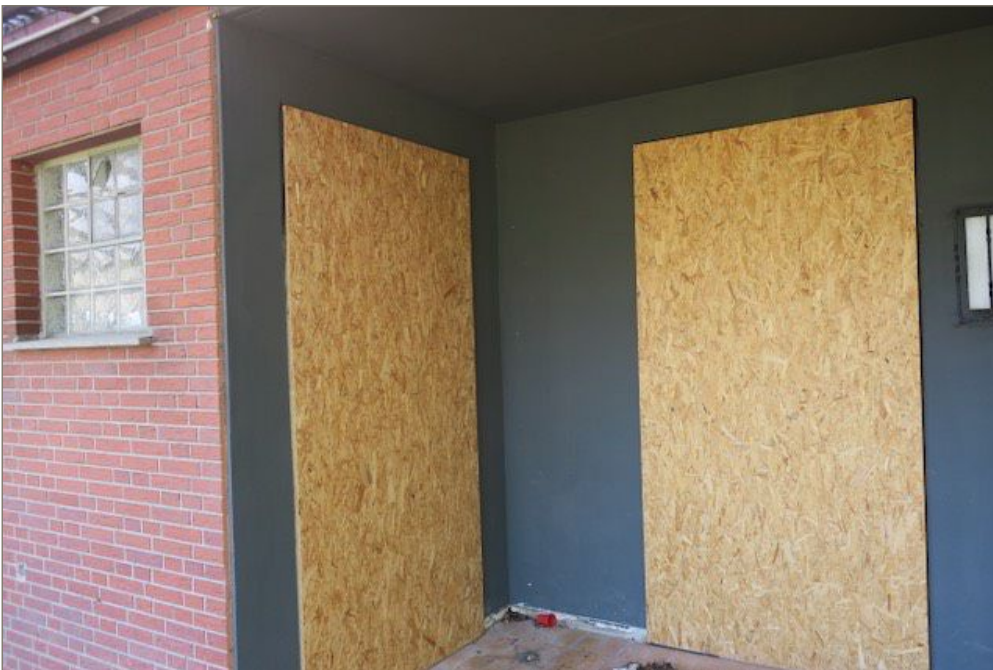
Foto 6: Verschlossene Ge- bäudeöffnungen
