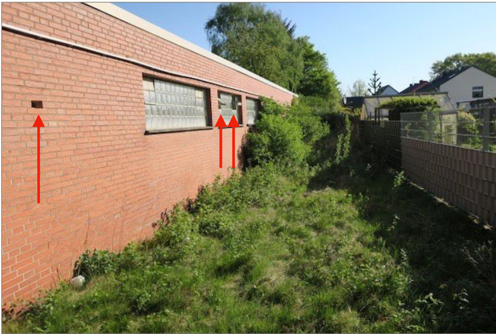
Foto 8: Südöstliche Fassade mit kleinen Gebäudeöffnungen als potentielle Eintrittspforte für Fledermäuse oder Vögel, mit vorgelagerter Brachfläche
