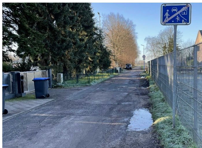
Bild 11: Westlicher Abschnitt Straßburger Straße, Blickrichtung Westen
