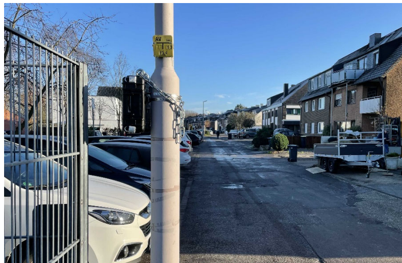
Bild 10: Westlicher Abschnitt Straßburger Straße mit Querparkplätzen, Blickrichtung Osten
