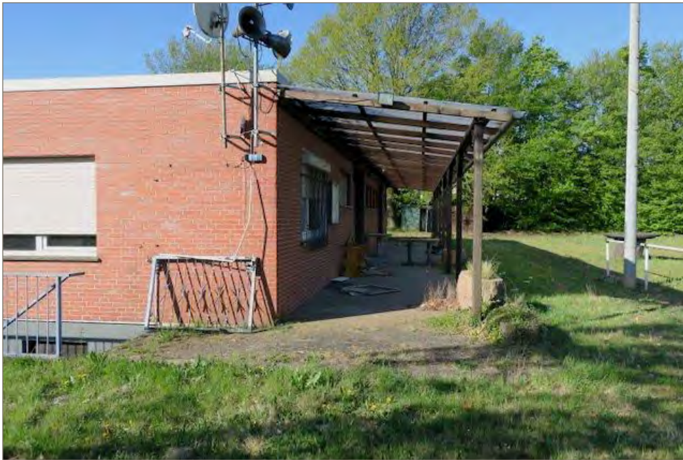
Foto 5: Aufgelassenes Vereinsheim mit Nebenflächen (von Osten)
