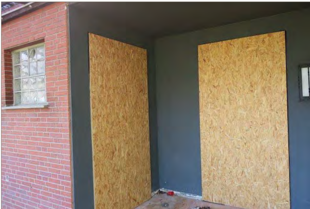
Foto 6: Verschlossene Gebäudeöffnun- gen
