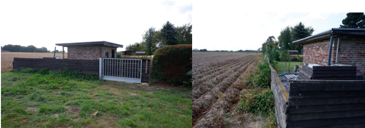
Abbildung 15: Einfriedung des Flurstückes 113/28 mit Bretterzaun; Gartenhaus in massiver Bauweise auf Flurstück 113/28, Blickrichtung Westen.
