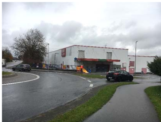
Foto 2: Zufahrt von der Linnicher Straße (B 57)
