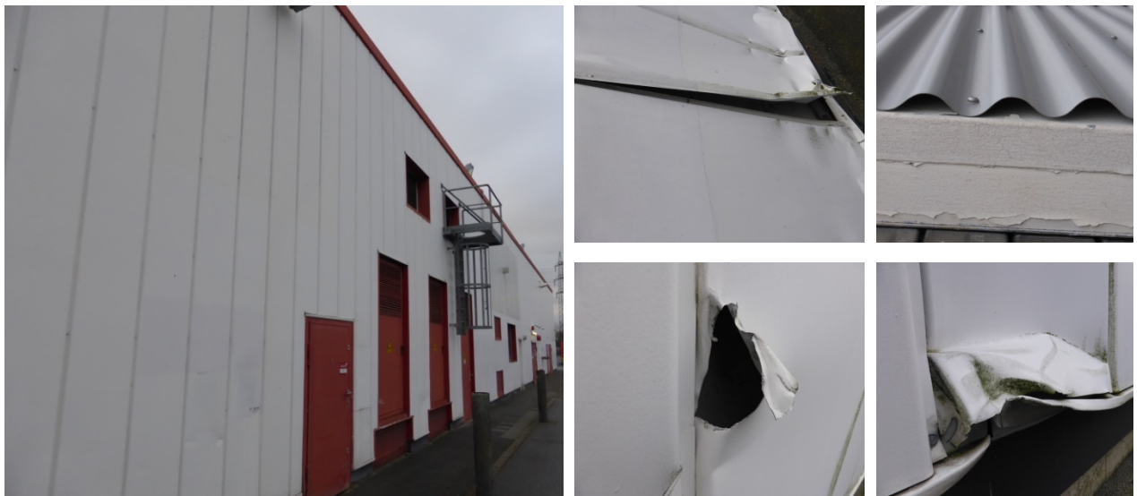
Abbildung 3 Fassade des Fachmarktes mit unterschiedlichen Löchern und Spalten in der Fassadenverkleidung.
